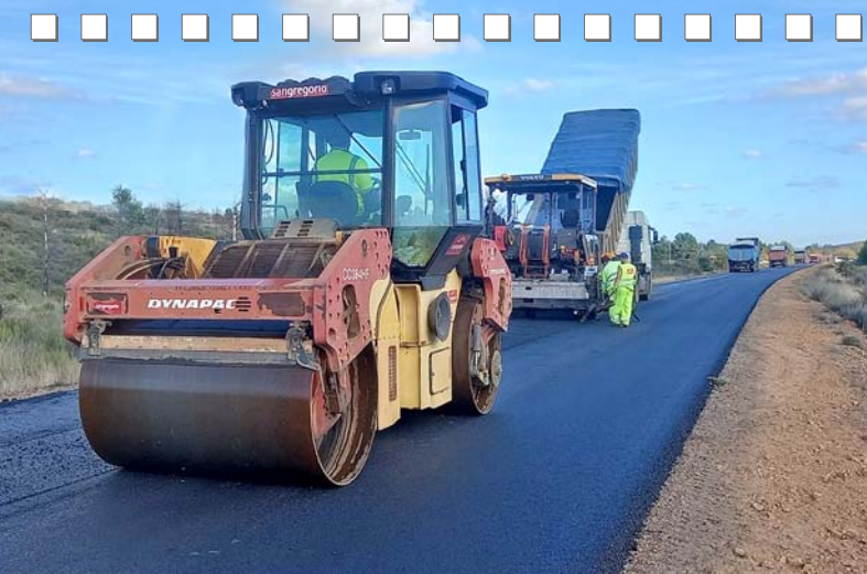
Maria J. Álvarez González, ZA-P1407 Refuerzo de firme
