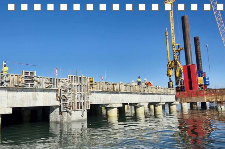
Luis A. García Payo, Tacón y una rampa para tráfico rodado, Puerto de Santander.
