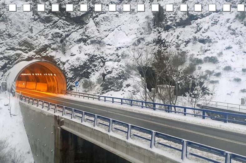
Alberto Neira, Túnel del Tueiro en T.M. de Villamanín (León)
