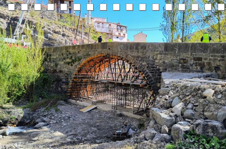
David Martínez Benito, Reparación del puente de la LR-286 sobre el río Cidacos en Enciso. (La Rioja)
