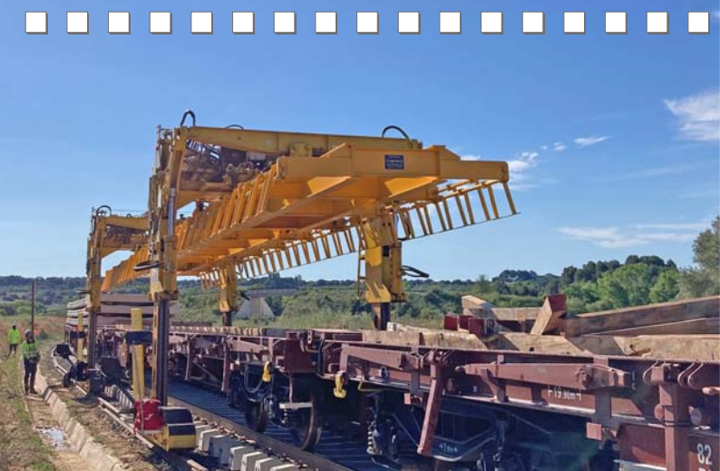
Santiago Álvarez Prada, Renovación vía Canfranero (ADIF), Tramo Ayerbe-Caldaerenas (Huesca)
