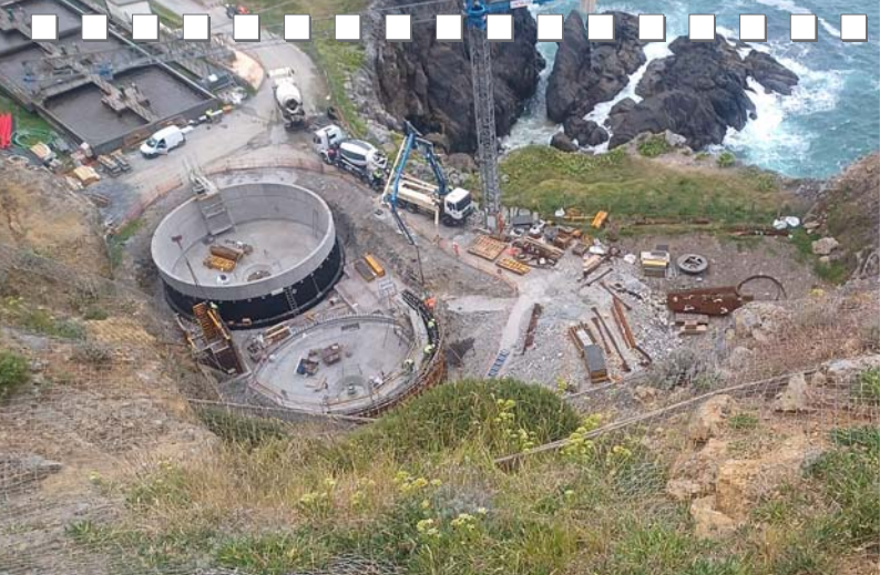
Luis A. García Payo. Ampliación y mejora EDAR Bakio. (Vizcaya)
