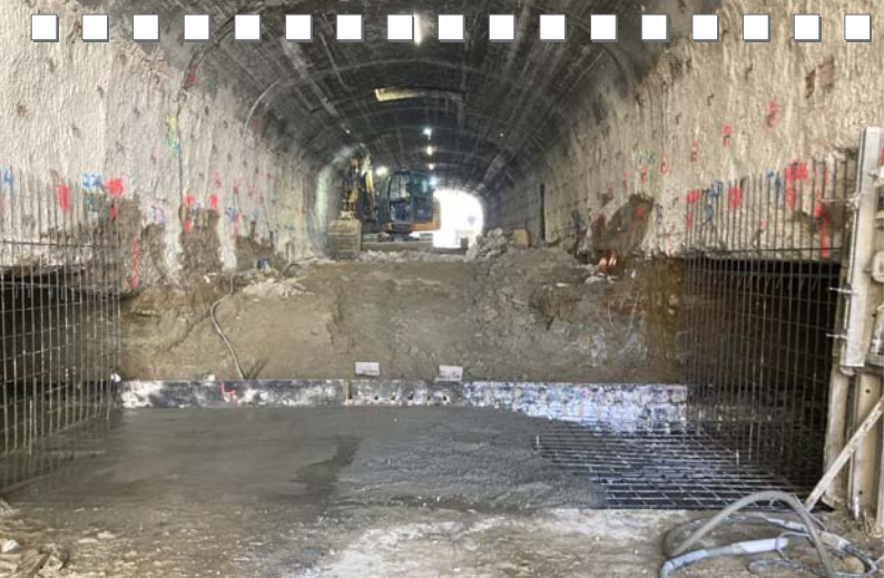
Ángel M. Cuevas, Ampliación tunel de Labradores en Valladolid
