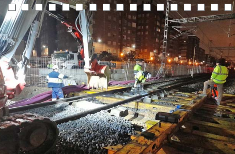
M. Teresa Monje Hernández, Apeo vía túnel Calle Padre Claret en Valladolid
