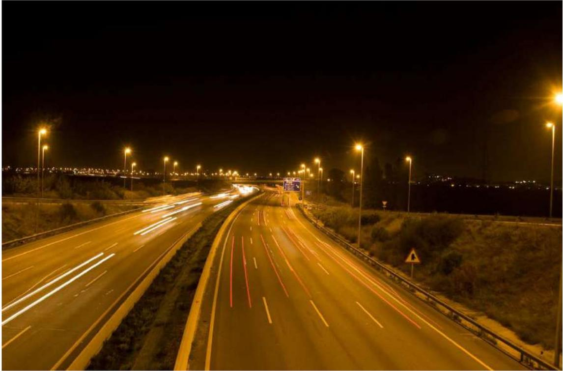
Fotografía 3. Autovía A-2. Sección tipo con dos calzadas y cuatro carriles cada una. Iluminación con tecnología VSAP. Interdistancia 40 m. Tipo de implantación: axial.
